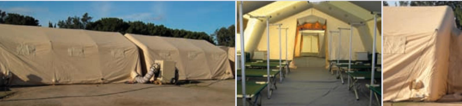
**Estructura:** arcos hinchables de tejido de poliéster hermético (1.100 g/m<sup>2</sup>), recubiertos por las dos caras con PVC. Varillas desmontables de aluminio entre los arcos en los aleros y el techo. Cada arco es hinchado por separado y está equipado con una válvula de seguridad para evitar el exceso de presión. Los arcos van unidos a las paredes mediante velcro, y pueden ser sustituidos de manera individual.
