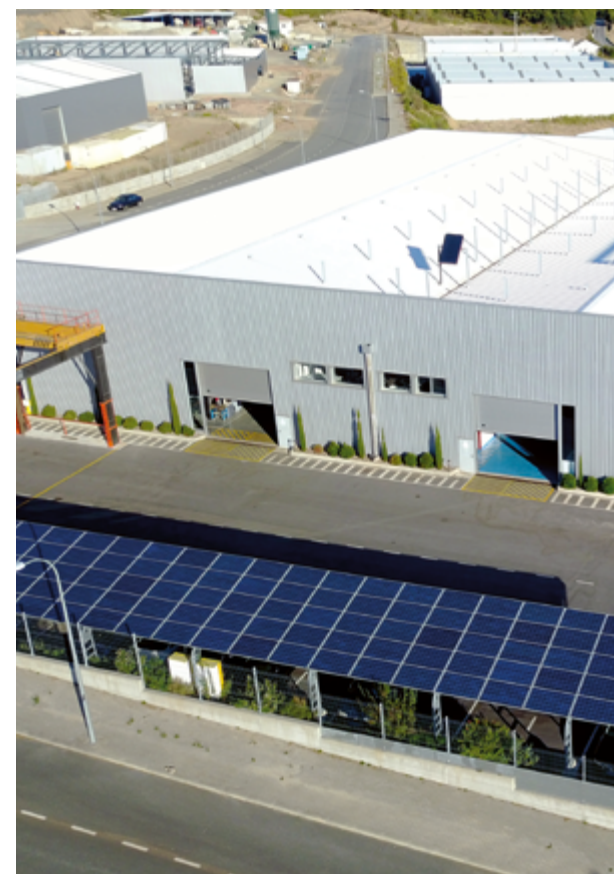
Fabricación de báculos solares y ensamblaje de luminarias en Bragança (Portugal)
